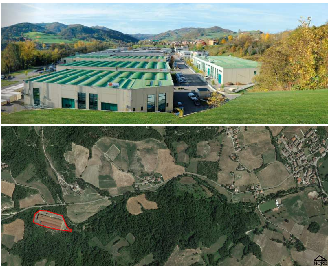
Fig. 1 Vista dell'attuale stabilimento a Viano Capoluogo (sopra) e localizzazione dell'area oggetto di variante (sotto)
